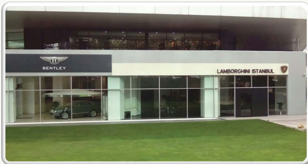
Монтаж электромеханических систем в административном здании Догуш ото повер центр (Doğuş Oto Power Center) и в шоуруме Bentley, Lamborghini
