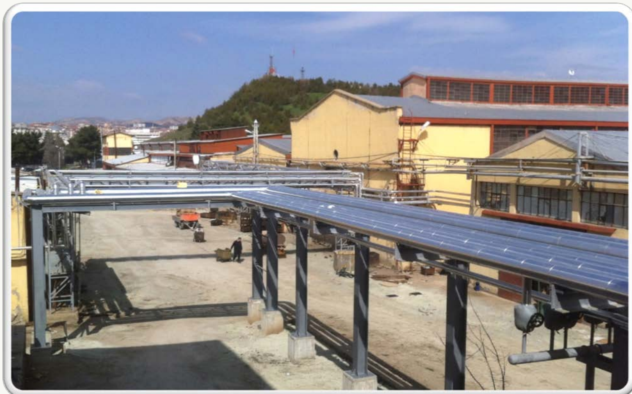
Институт инженерной химии в г. Кырккале. Обновление системы отопления патронного завода.
