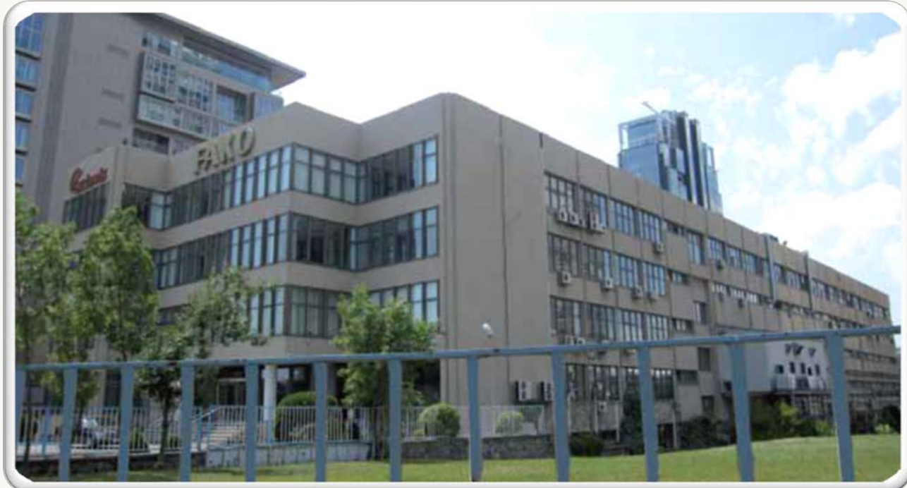
Дополнительные работы по установке противопожарных систем.
