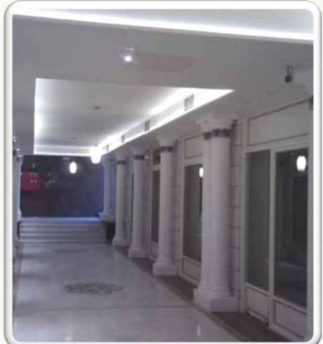
Все механические работы в Подземном Зале Художников в Умрание
