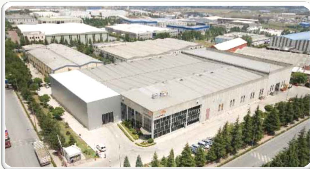
Механические сооружения Uginox фабричные здания в Gebze.
