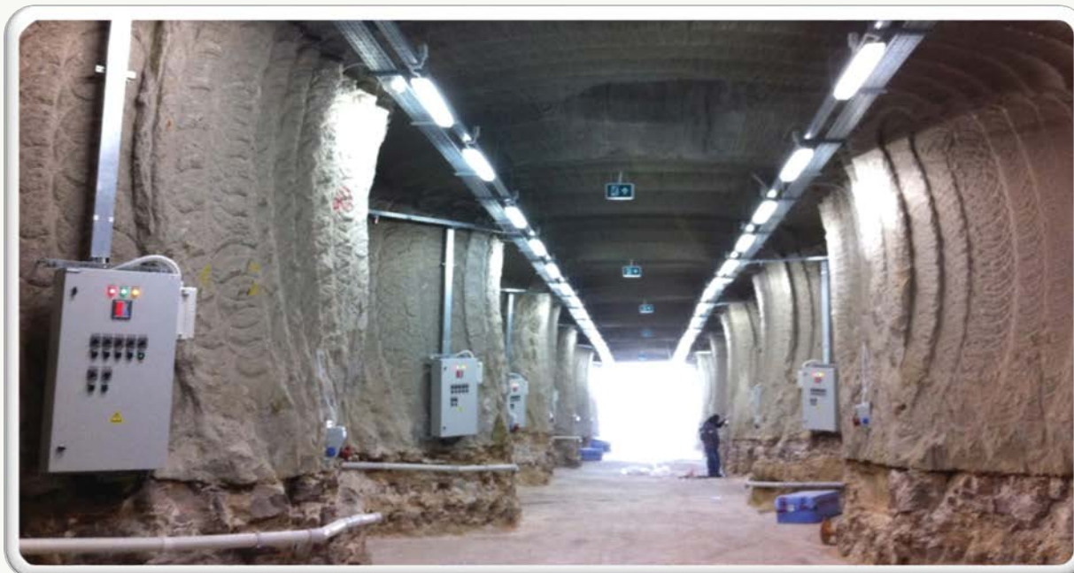
Система охлаждения подземных резервуаров Кютахья.
