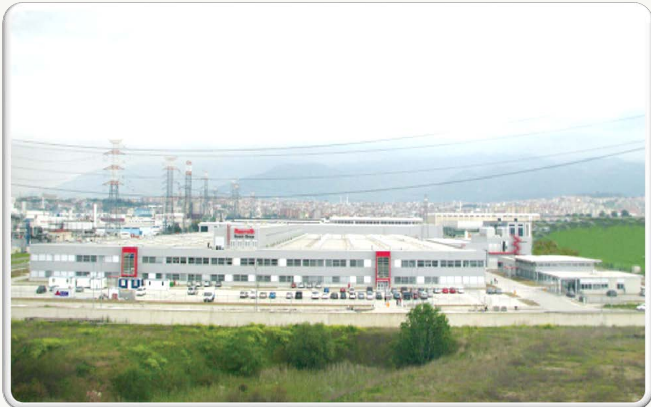
Все механические установки административного и производственного здания Bosch Rexroth в БУРСА.
