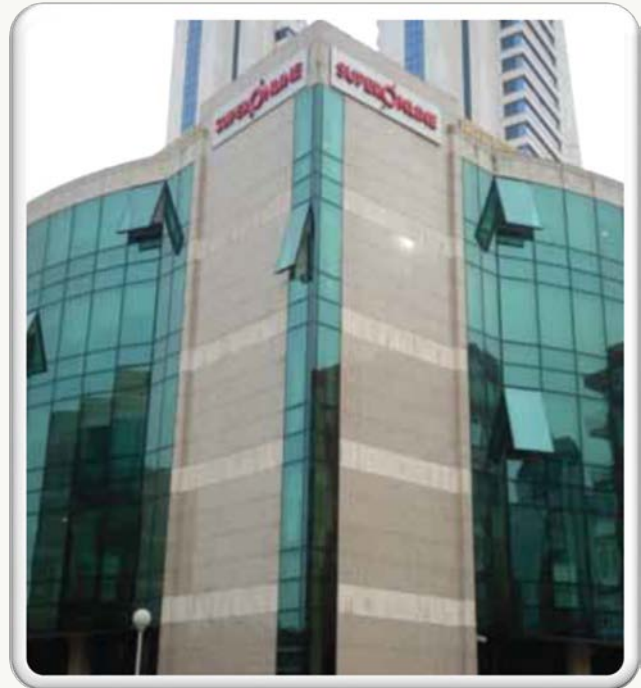
Механические работы в здании штаб-квартиры Supergonline.
