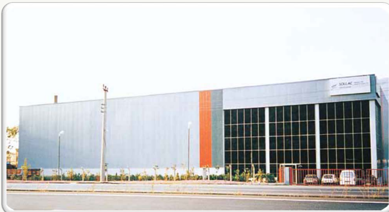
Механические сооружения Sollac фабричные здания в Gemlik.
