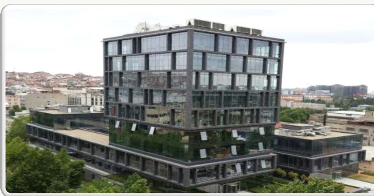
Проектирование, монтаж и обслуживание электромеханических систем в здании генерального управления Гозен холдинга.
