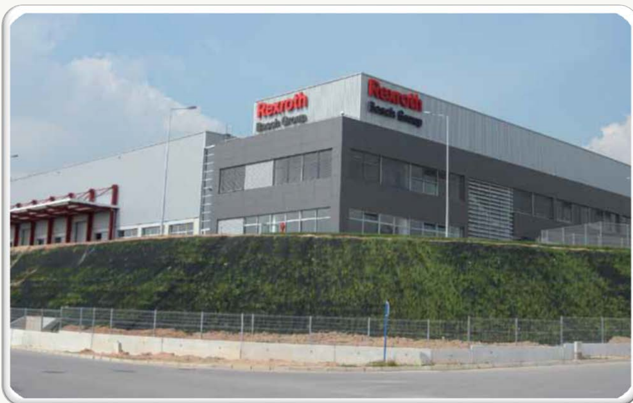
Все механические установки административного и производственного здания Bosch Rexroth в Гебзе.
