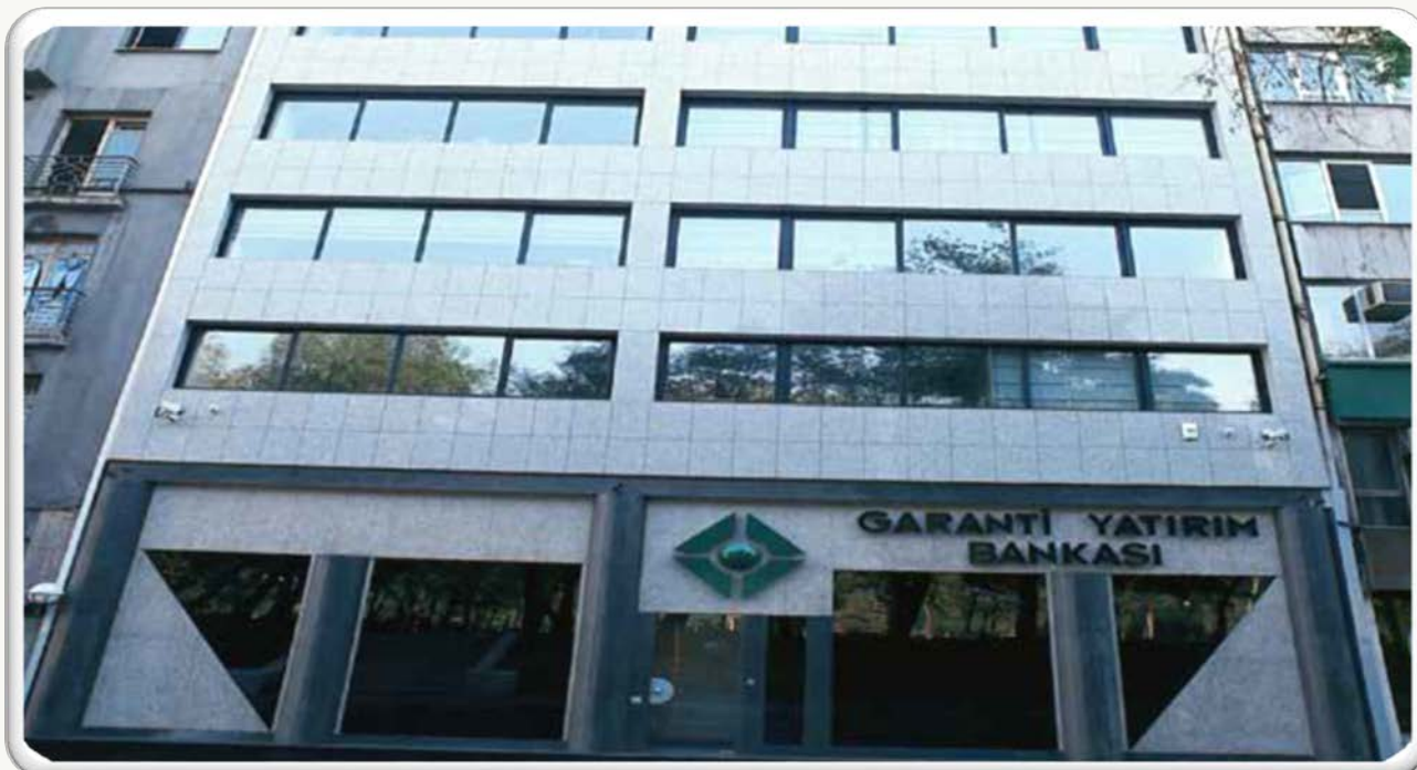
Все механическое оснащение и оборудование автоматического управления здания Главного Управления Гаранты Ятырым
