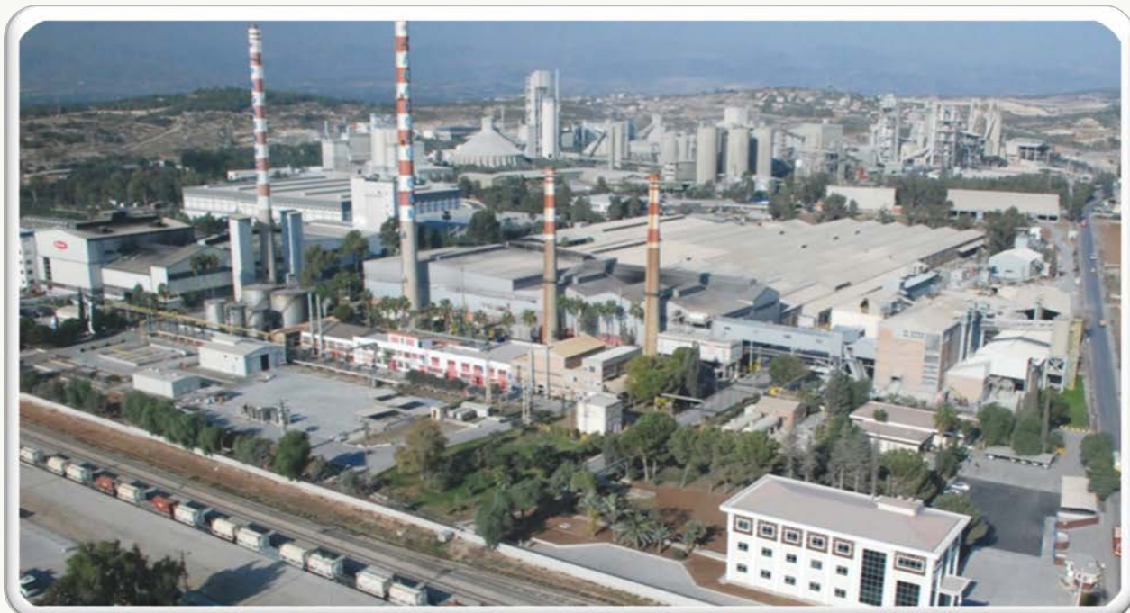
Выполнение работ, связанных с электро-механическим устройством систем абсорбционного охлаждения завода "Mersin Пашабахче".
