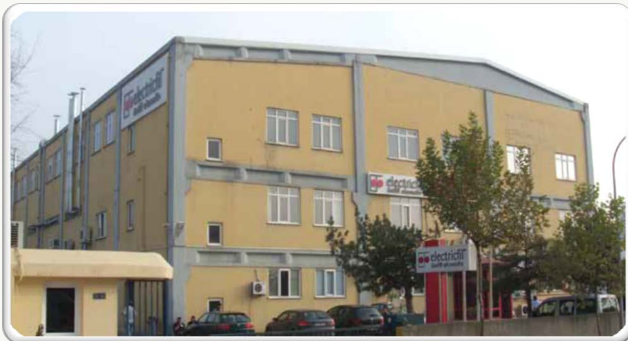
Все механические установки на производственных площадях фабрики Электрифил Унифил и автоматизация систем в здании.
