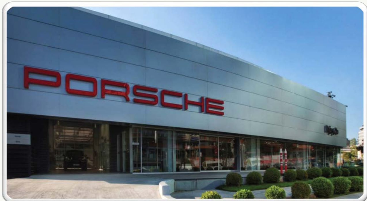
Маслак Догуш авто инженерные системы шоурум и сервисной зоны.
