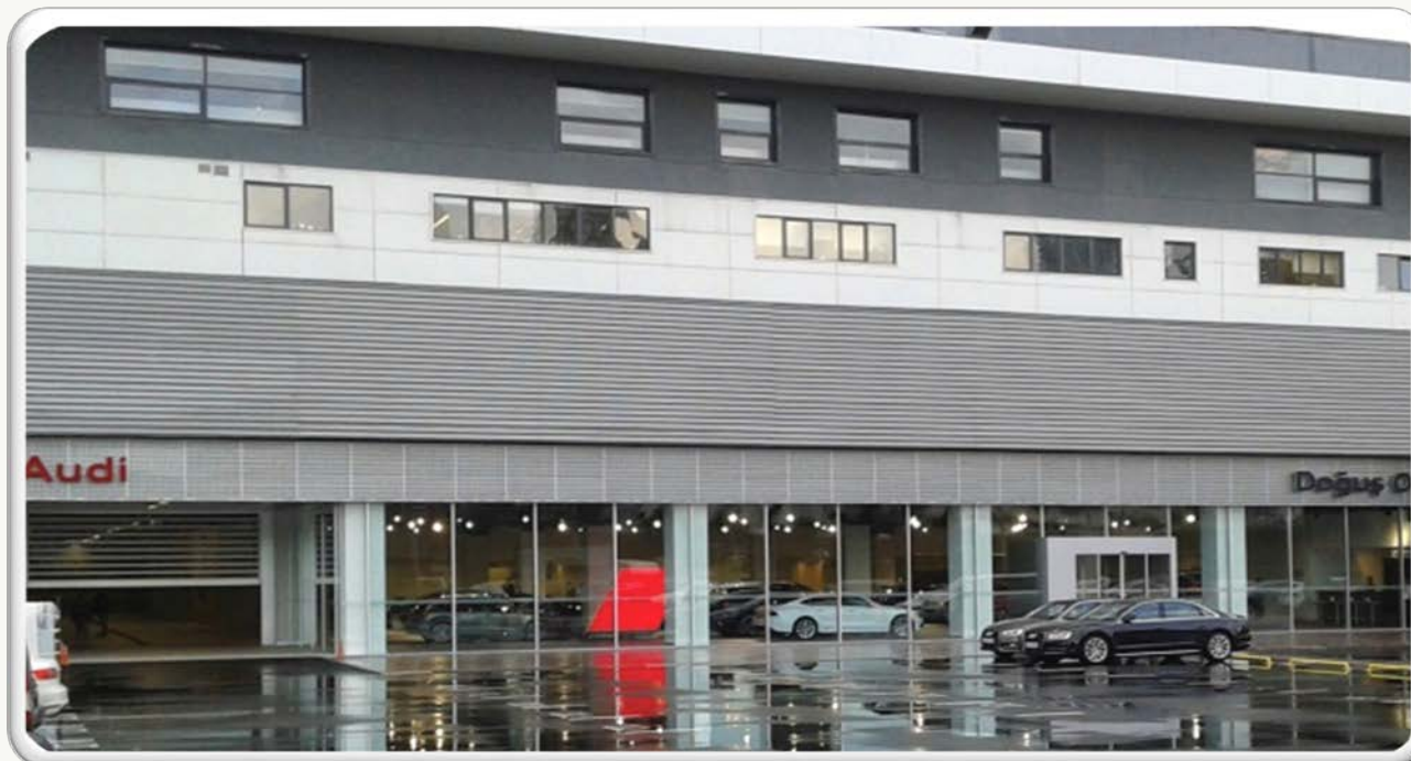
Монтаж электромеханических систем в административном здании, здании сервисного обслуживания Догуш ото повер центр (Doğuş OtoPowerCenter) и в шоуруме Audi, Skoda
