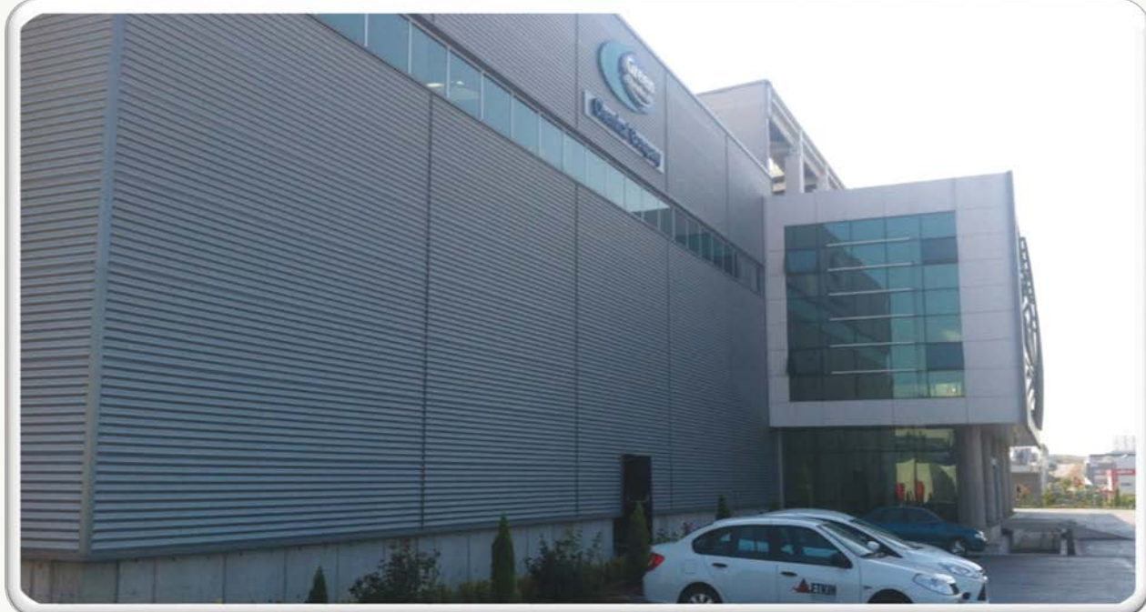
Механический монтаж завода Gebze Green Chemicals
