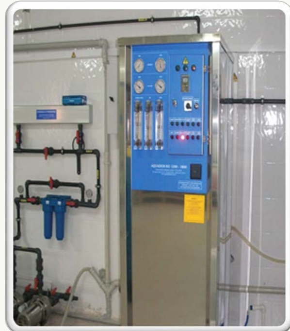
Осуществление проекта механической установки и выполнение практических работ в Кахраманмараш Центре Диализ
