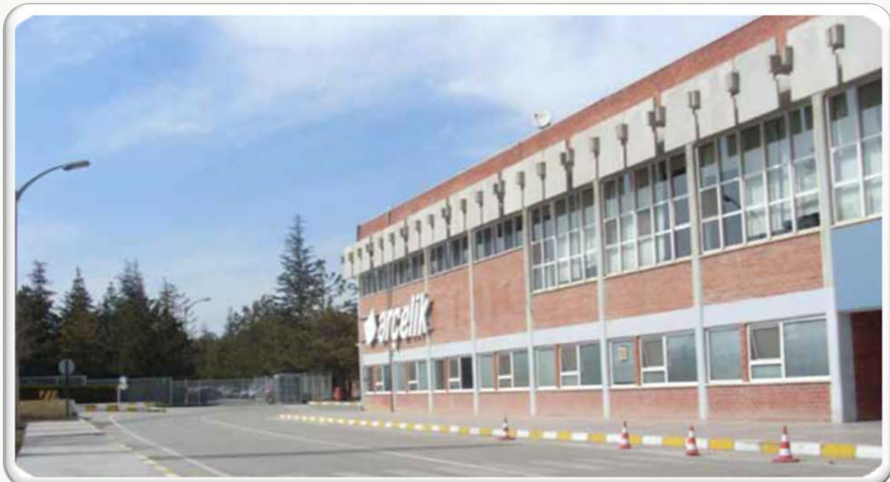
Промышленное оборудование пожаротушения для магазинов завода Арчелик Эскишехи
