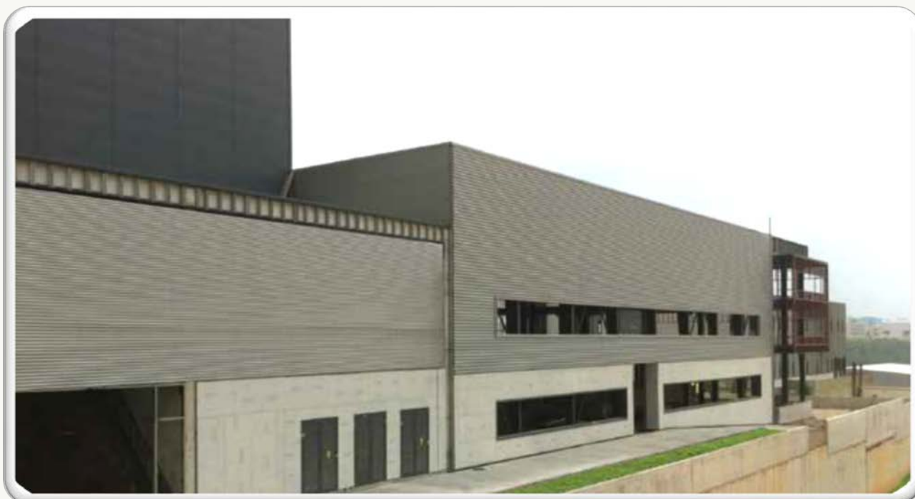
Все системы автоматического и механического контроля здания фабрики "Оргакем".
