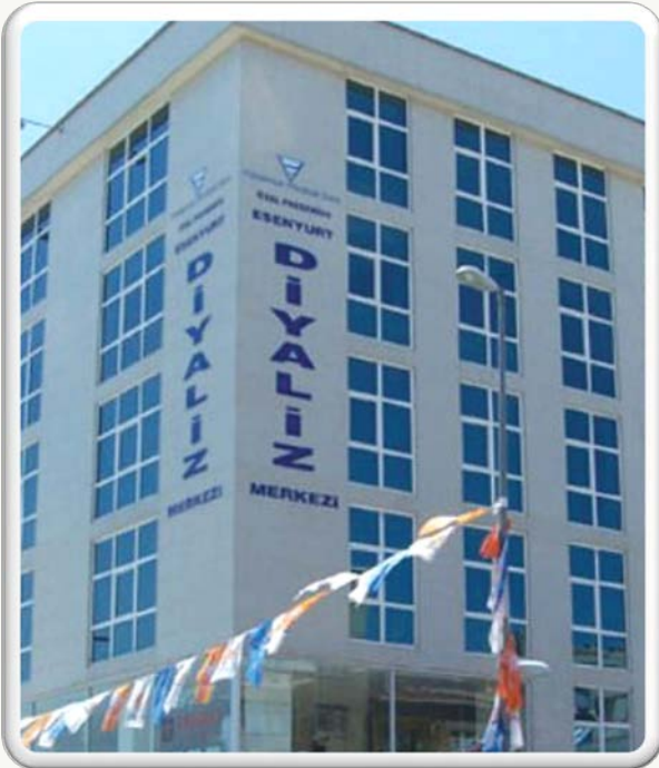
Осуществление проекта механической установки и выполнение практических работ в Эсенюрт Центре Диализ.
