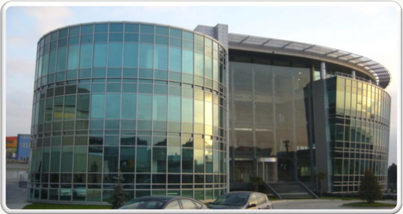
Механические системы офисов административного здания Каяляр Кимия.
