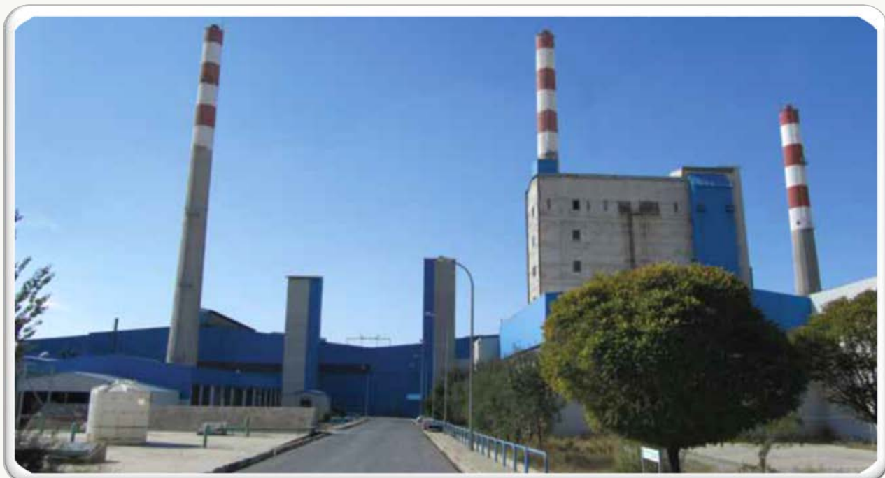
Выполнение работ, связанных с электро-механическим устройством систем абсорбционного охлаждения завода “Eskişehir Пашабахче”.
