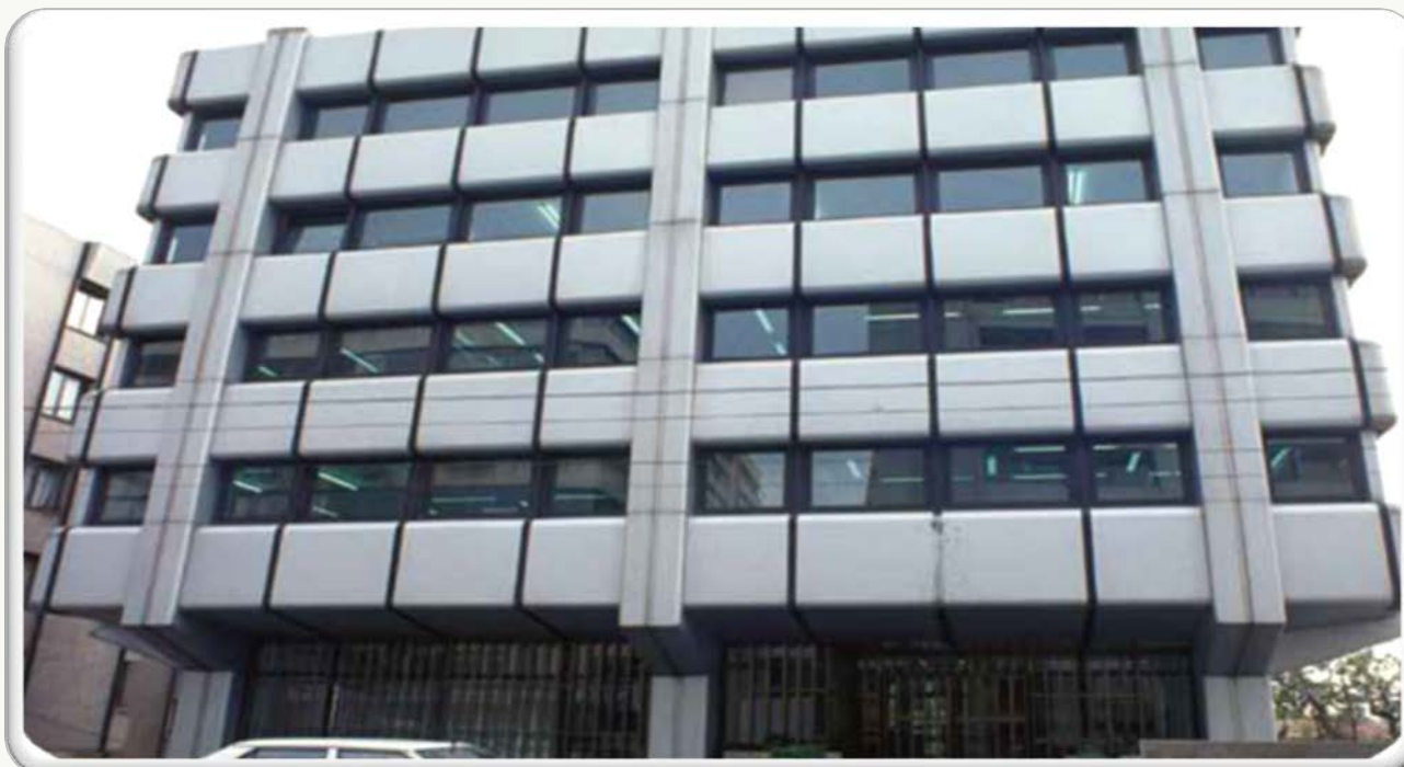
Все механическое оснащение и оборудование автоматического управления здания Главного Управления Гаранты.
