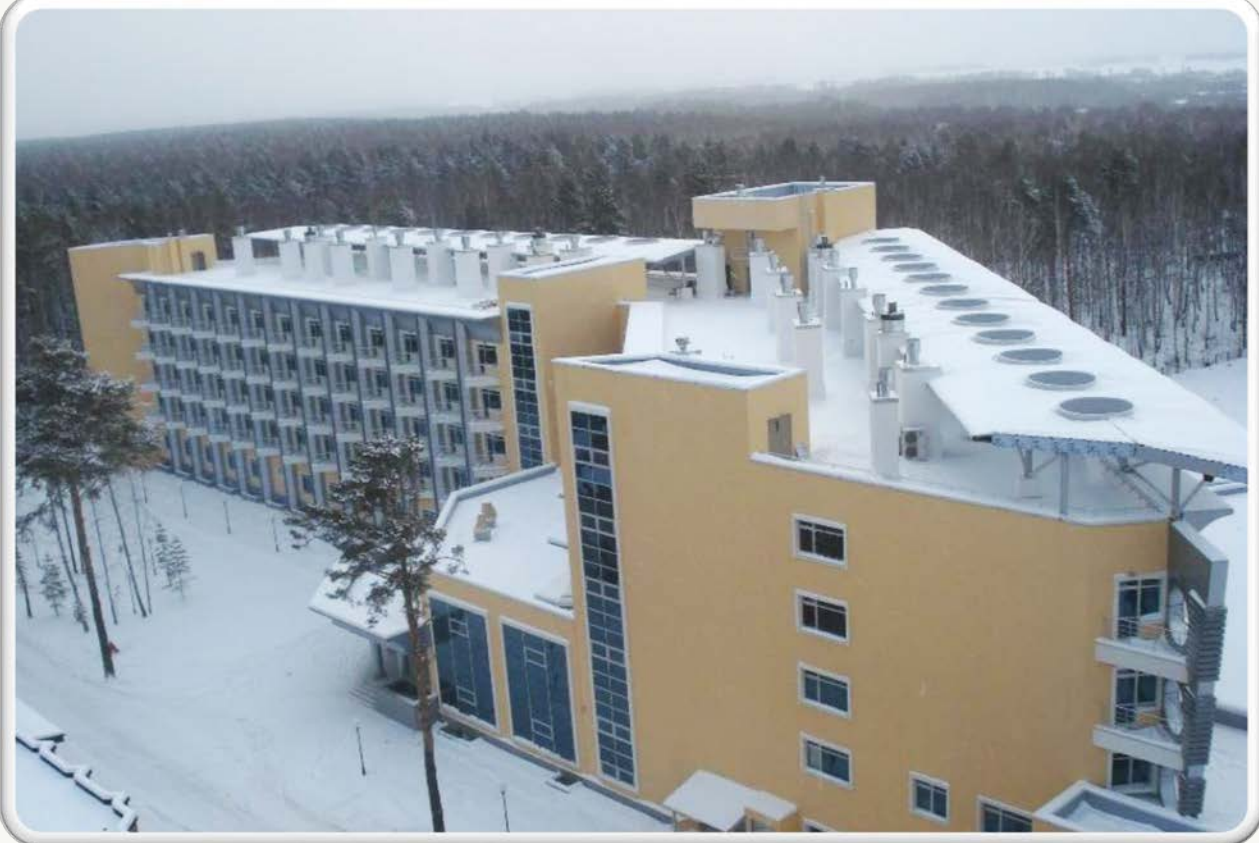
Механическое оборудование для инфраструктуры и наземных сооружений Тюменского.
